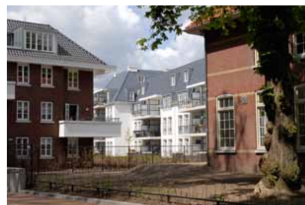
Project 'Castellanie' in Loon op Zand
